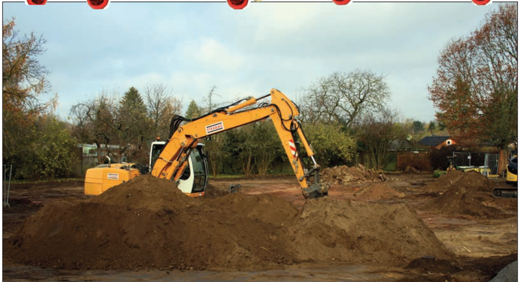
Ein Bagger hebt am Eingang Hühfnerweg Erde aus. Federführend bei den Arbeiten ist die österreichische Strabag, eines der größten Bauunternehmen Europas. Foto: Bothe
