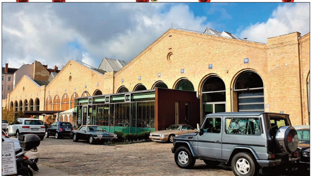
Die „Classic Remise Wiebestraße“ von außen, man erkennt noch die Formen des ehemaligen Straßenbahndepots.
